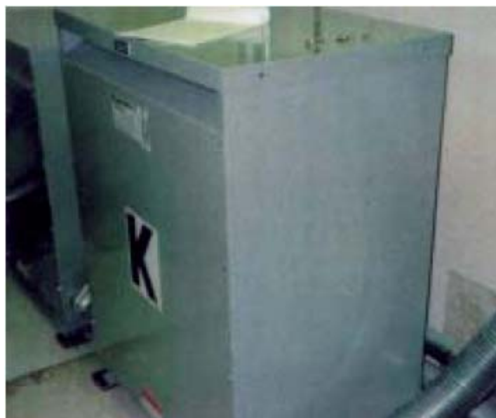
Figura 9: Transformador de interior de categoría K.
