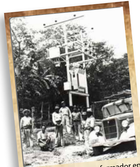
Colocación de transformador en Subestación La Ceiba en agosto de 1939.
